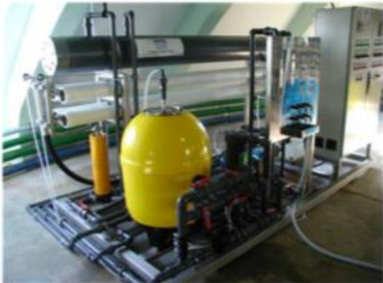
Central OI 1,25 m<sup>3</sup>/h (30 m<sup>3</sup>/d), 2,54 kWh/m<sup>3</sup>.
